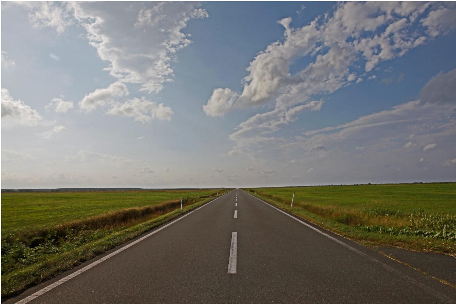
エサヌカ線の空に溶けこむ直線道路
