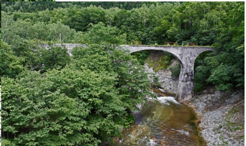
国道から見える旧士幌線のアーチ橋
