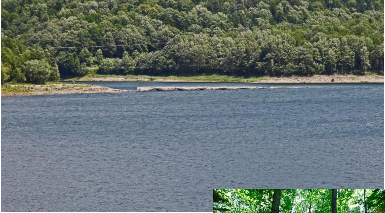
タウシュベツアーチ橋 水没寸前
